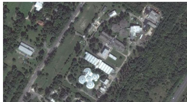
Használaton kívüli „klasszikus” barnamezős terület épületállománnyal – volt Újpesti Víztisztítómu
